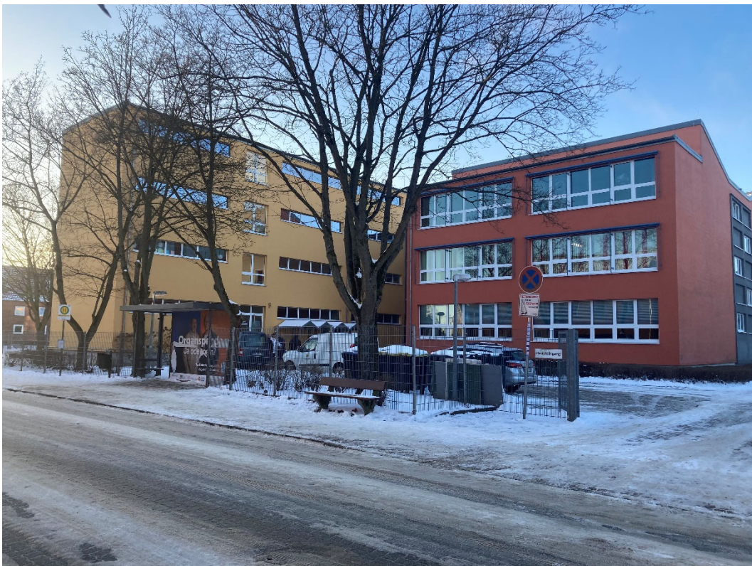
Blick auf das Schulgebäude (Rückseite und Baustellenbereich) von der Thomas-Mann-Straße
