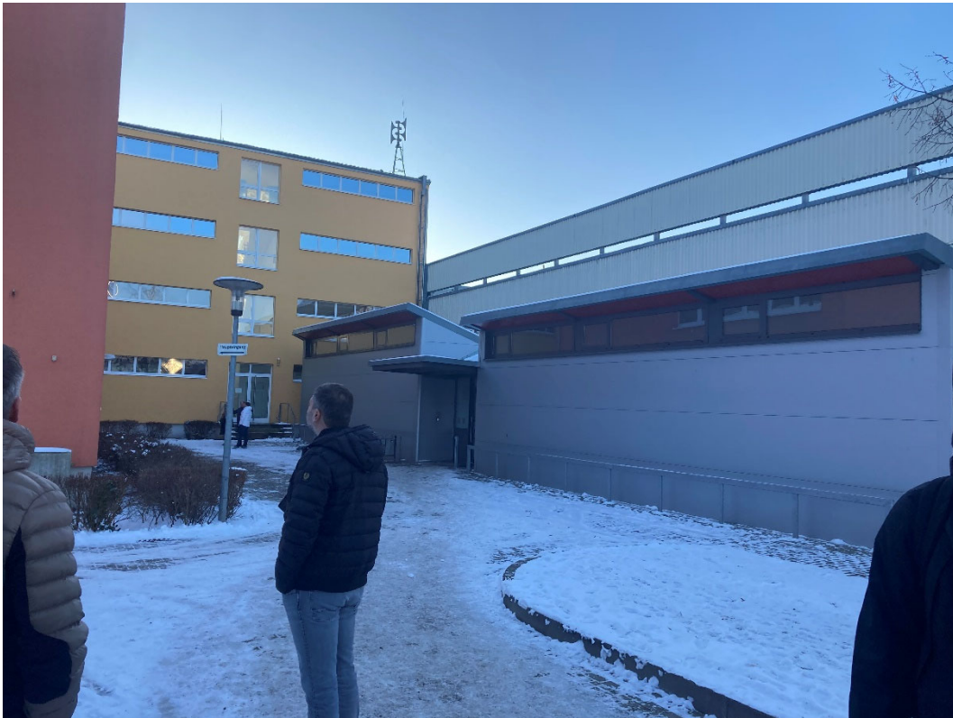
Schulgebäude und Sporthalle mit vorgelagerten Umkleidekabinen
